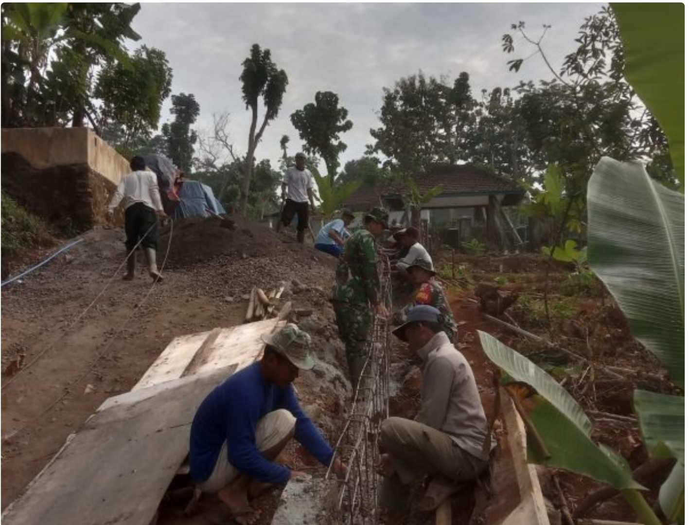
(Foto istimewa ) kegiatan pembuatan talud tmmd sengkuyung tahap II
