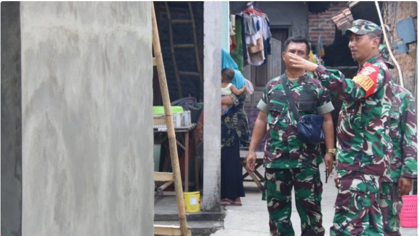
(Foto istimewa ) dansargas tmmd tinjau lokasi RTLH
